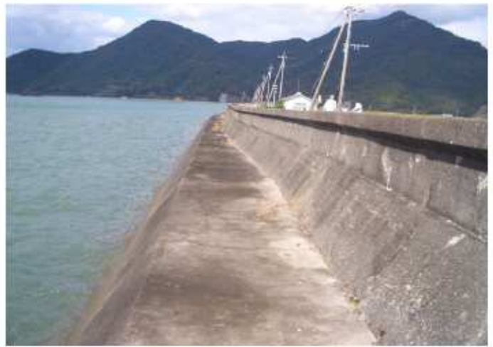
海岸の防災施設
