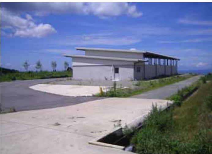
完成した堆肥施設
