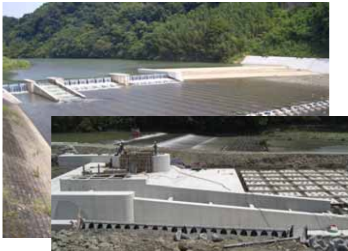
完成した堰と施工状況
