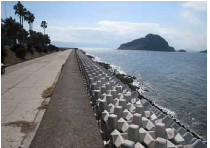
調査区間の海岸保全施設
