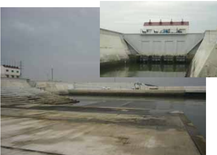
完成した漁港施設と樋門
