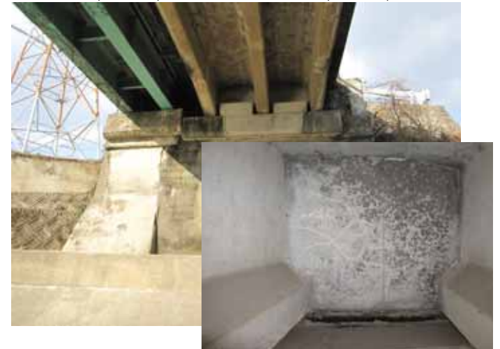
橋梁の機能診断
