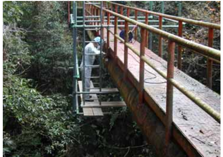
水管橋の機能診断
