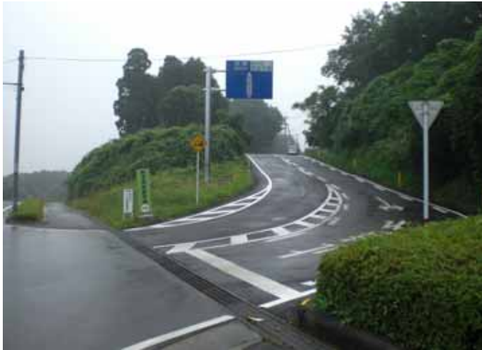
完成した道路の起点
