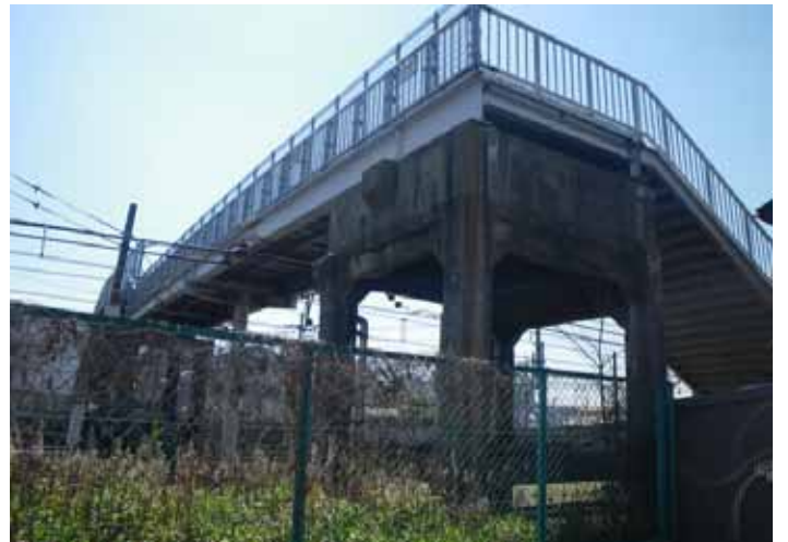
耐震補強調査の対象こ線梁
