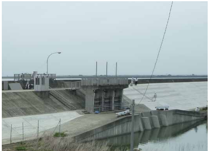
地区の排水樋門
