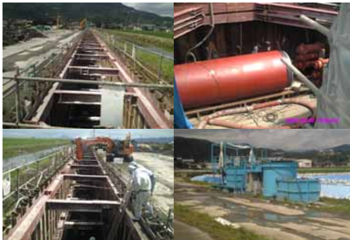
管水路の施工状況
