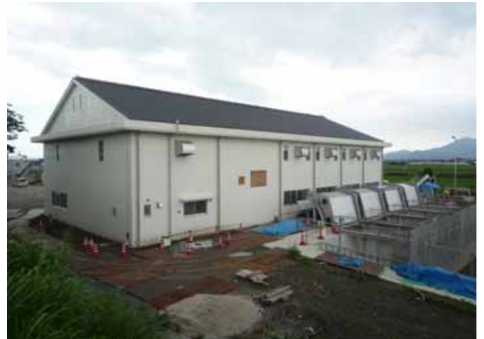
建設中の排水機場
